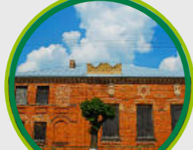
BUDYNEK SYNAGOGI Z 1927 ROKU W MILEJCZYCACH / FORMER SYNAGOGUE, BUILT IN 1927 IN MILEJCZYCE
