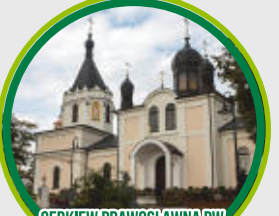
CERKIEW PRAWOSŁAWNA PW. ŚWIĘTYCH APOSTOŁÓW PIOTRA I PAWŁA Z XIX WIEKU W SIEMATYCZACH / THE GREEK ORTHODOX CHURCH OF SAINT PETER AND PAUL THE APOSTLES, SIEMATYCZE
