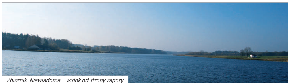
Zbiornik Niewiadoma – widok od strony zapory
