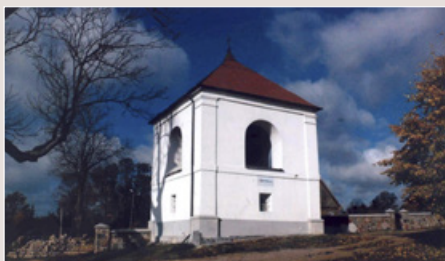
Dzwonnica parafii pod wezwaniem św. Trójcy w Dziadkowicach
